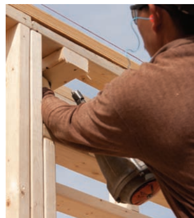
La penetración del clavo a través de la madera es una preocupación especial cuando la pieza se posiciona con la mano
